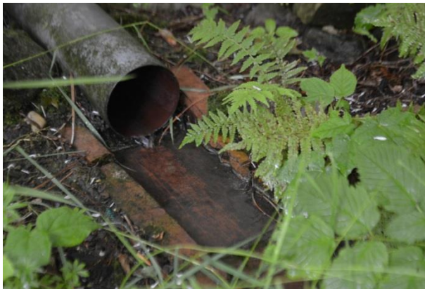
Abb. 13: Ausgebundenes Fallrohr in Grün integriert
