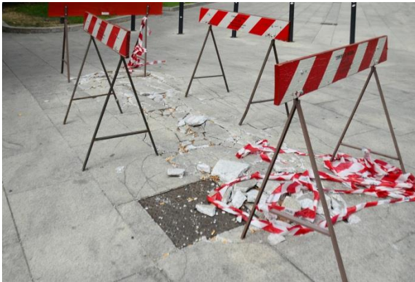
Abb. 3: Plattenaufspaltung durch zunehmende thermische Belastung
