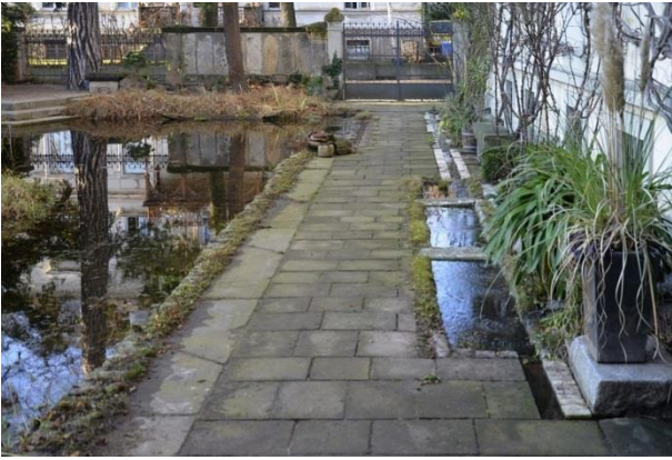
Abb. 23: Kleine Wasserbecken ergänzen die Wasserableitsysteme und dienen als Sandfang
