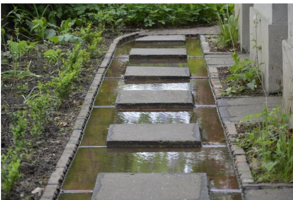
Abb. 17: Trittplatten ermöglichen Begehbarkeit und temporär Wasserableitung bei teilweiser Versickerung
