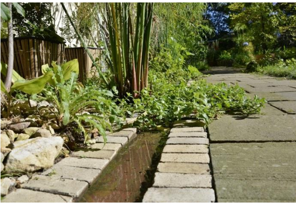
Abb. 25: Versickerungsrinnen leiten Wasser in die Pflanzflächen
