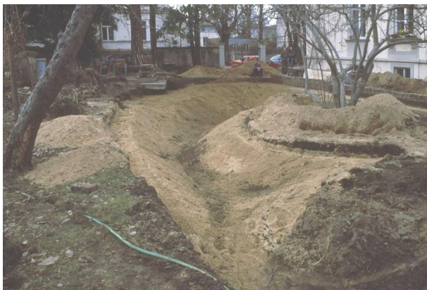
Abb. 35: Teich modelliert und mit Sand zum Einbringen von Folie und Schutzvlies vorbereitet
