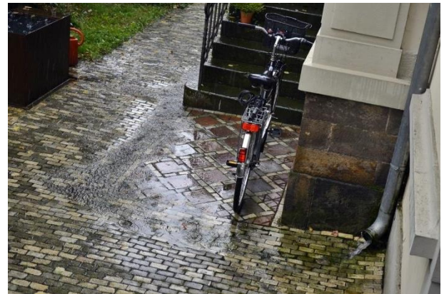
Abb. 14: Offene Regenwasserführung über Mulden im Gehbahnbelag
