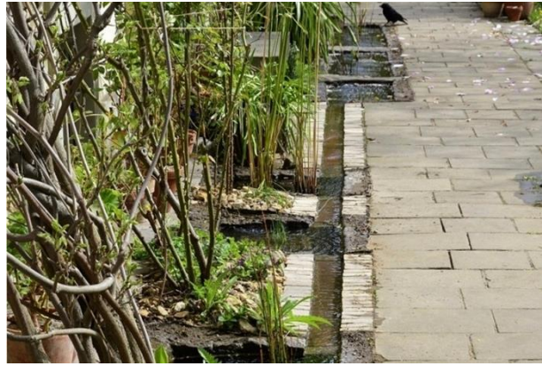
Abb. 24: Versickerungsrinnen zwischen den abgedichteten Becken kommen dem Fassadengrün zugute
