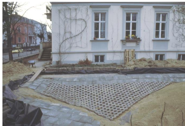
Abb. 36: Betonplatten und -steine schützen besonders strapazierte Teile des künftigen Teichs, Uferstreifen abgeflacht
