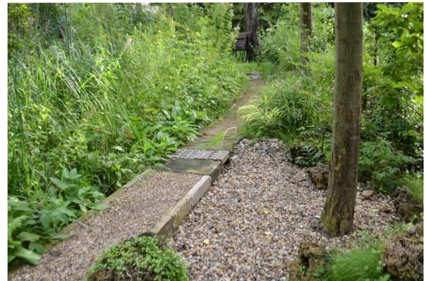
Abb. 8: Weg erhöht, entwässert in angrenzende tiefliegende Bereiche
