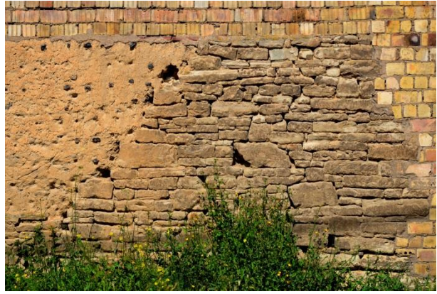
Abb. 40: Mauer aus Lehm, Kalk- und Ziegelsteinen zum Schutz vor Wind und Austrocknung, bietet den Anpflanzungen Schatten
